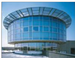
Fergamma-Büros, Itálie Architekt: Amerigo Berto
